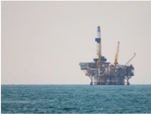
Marine - Offshore 海运业 - 钻井平台
