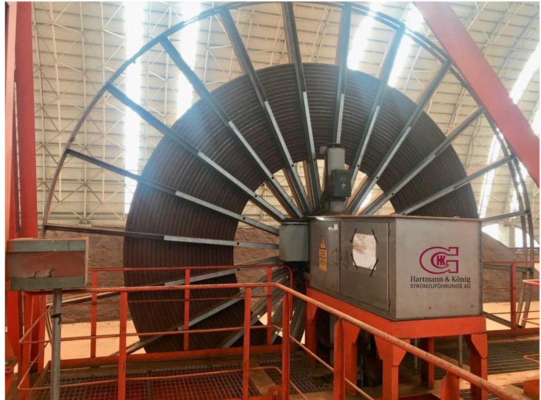
五矿曹妃甸矿石料场混匀堆料机
